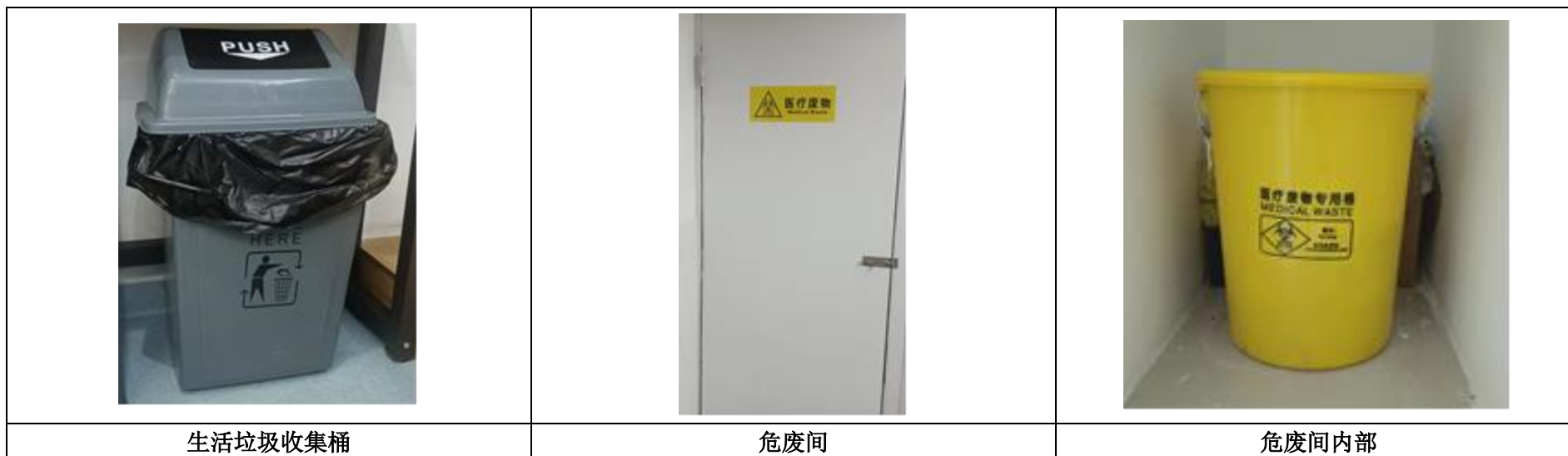
图 4.1-3 项目固废治理措施
